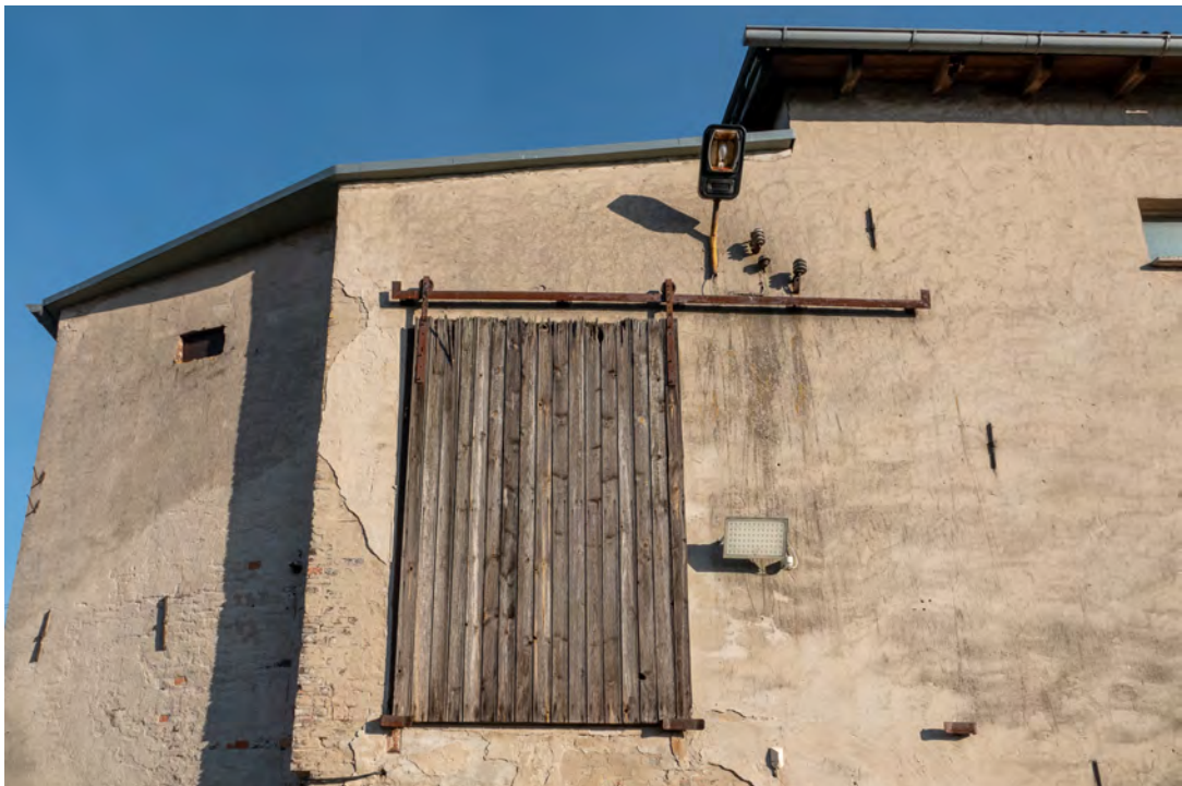
Schiebetor Treppenhaus 2 - vermutete Einflugöffnung für Kleinvögel und Fledermäuse
